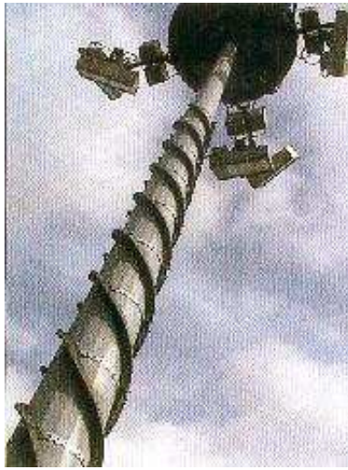
Abb. 11. Die Einstellung der schwingungserregende Wirbelablösungen mittel Spiralrippe
